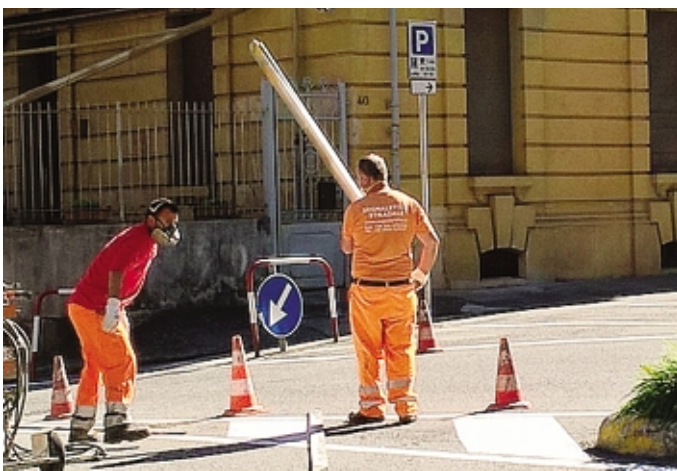
Nuova segnaletica orizzontale in via San Rocco a Morbegno
