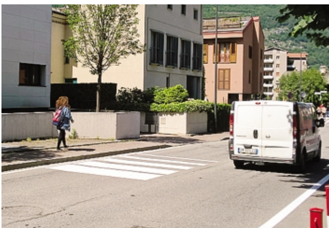
Un altro scorcio di via San Rocco coi lavori sugli attraversamenti
